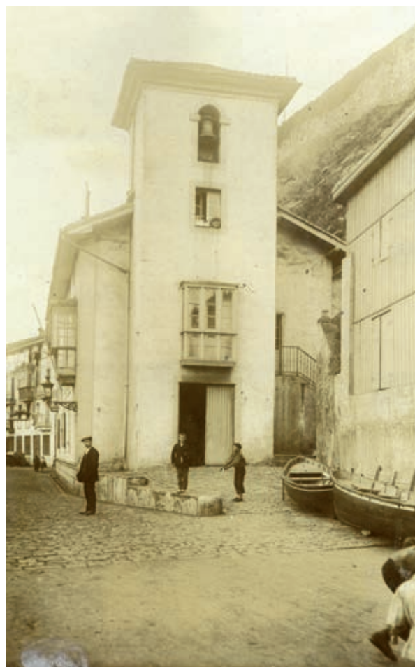
La Casa-Torre del Consulado cuenta con un campanario que emitía avisos de distinto tipo. En las Ordenanzas del Consulado se señalaba expresamente que en caso de incendio en algún navío el teniente debía hacer “llamada de gente con la campana de la torre de su habitación” para que colaboraran en su extinción.
