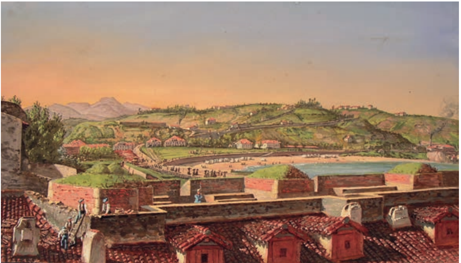
Panorámica sobre las murallas del frente de tierra. Aguada de Petit de Meurville, 1857-1863. Diputación Foral de Gipuzkoa.
