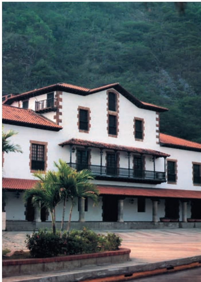
Casa-factoría de la Compañía Guipuzcoana de Caracas en La Guaira (Venezuela). Este edificio es para los venezolanos uno de los principales símbolos de su pasado colonial. En Puerto Cabello se conservan también otras edificaciones promovidas por la Compañía, como la "Casa Guipuzcoana" y la iglesia del Rosario. [Foto Gerardo Vivas].
