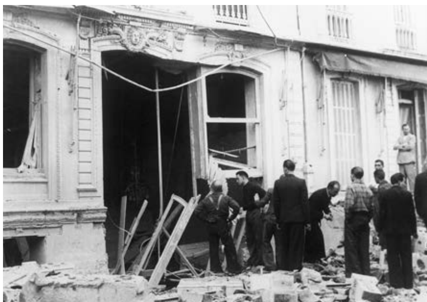
Destrozos causados en el paseo de La Concha por el bombardeo del acorazado España el 18 de agosto de 1936. Fototeca Kutxa.
